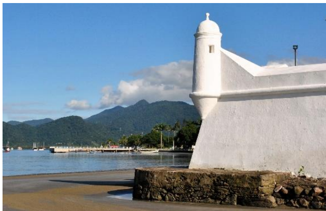
Fuerte São João, Bertioga, SP Fortaleza de São João, Rio de Janeiro, RJ Marcos Pertines / PMB André Vaz / COPPE_UFRJ
